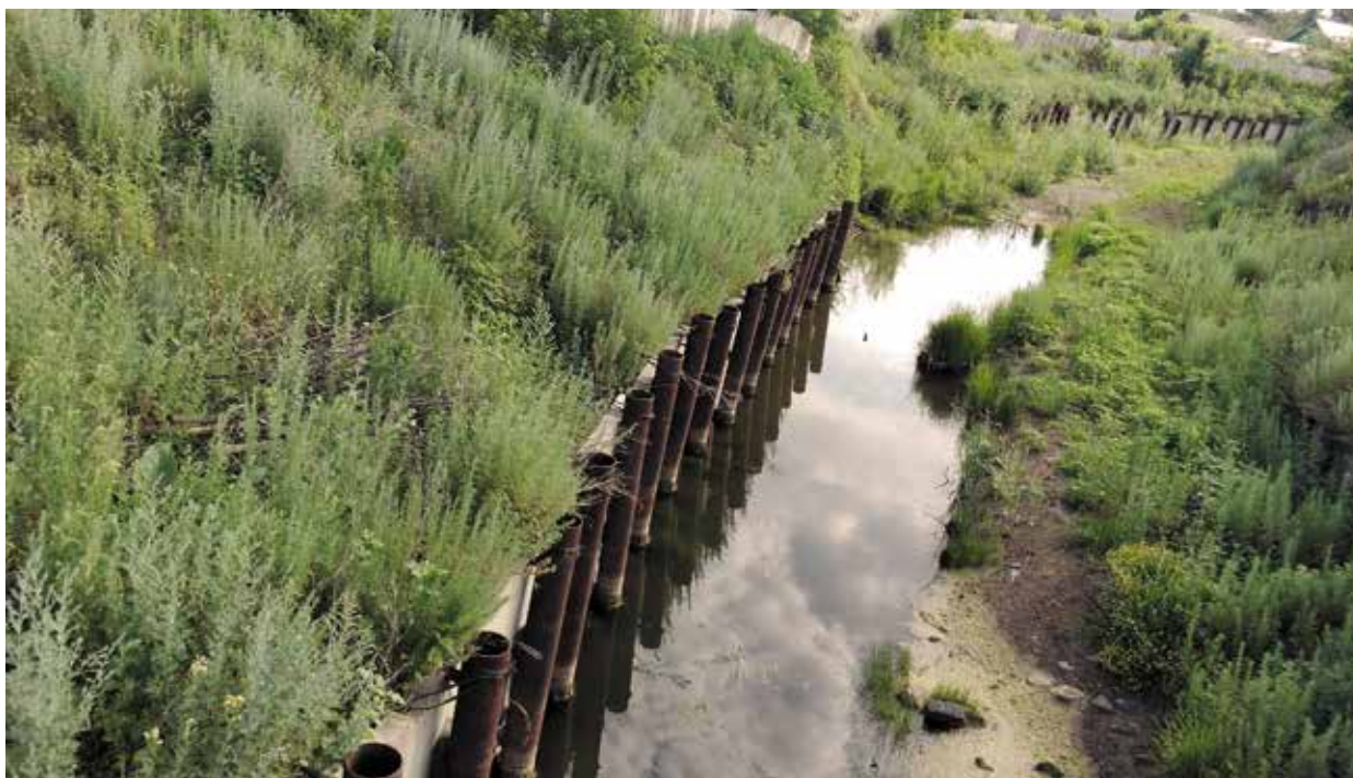
Рисунок 6.4. Пример вынужденной защиты берега после расчистки и углубления дна русла Фото: Д. Шаликовский
