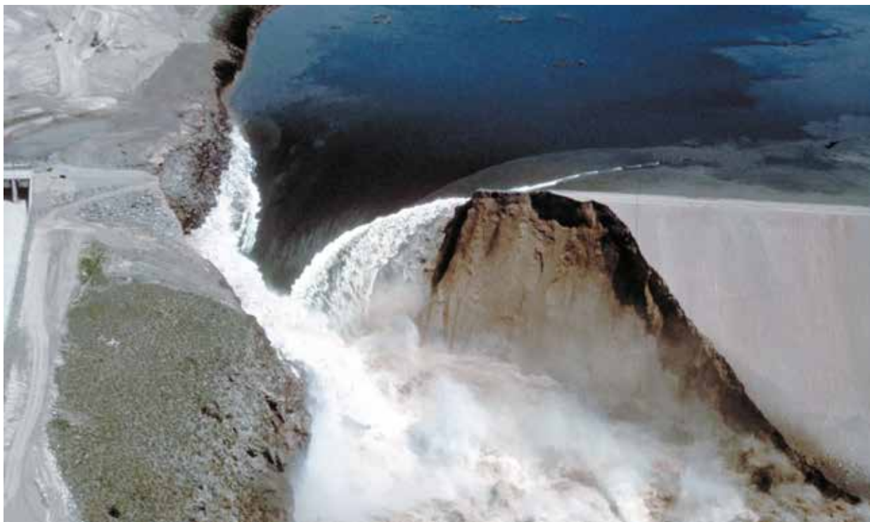
Рисунок 1.5. Разрушение плотины Тетон в штате Айдахо, США Источник: waterarchives.org
