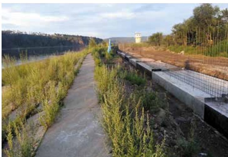
Рисунок 3.23. Нарращивание гребня дамбы в уезде Мохэ в 2015 г. Предоставлено Международной коалицией «Реки без границ»
