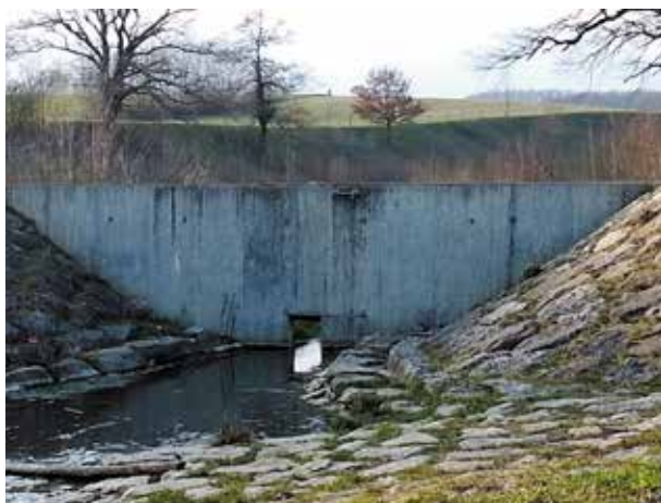
Рисунок 6.2. Противопаводковая плотина автоматического действия, пригород Женевы Предоставлено Международной коалицией «Реки без границ»
