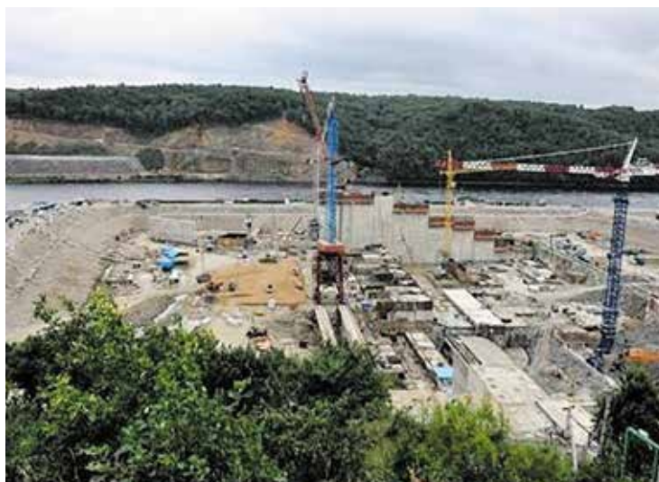
Рисунок 7.8. Строительство Нижне-Бурейской ГЭС на притоке Амура — реке Бурея (август 2014 г.) Фото: А. Жданова
