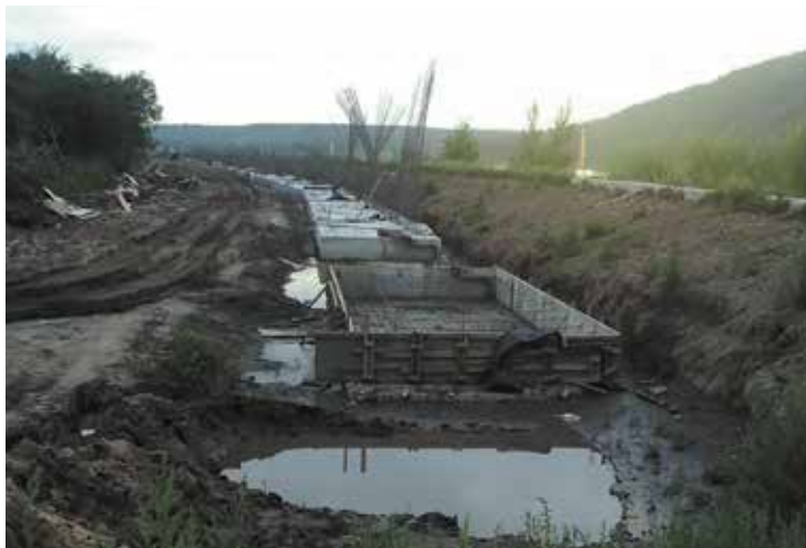
Рисунок 3.22. Строительство новой дамбы вдоль Амура в уезде Мохэ в 2015 г. Предоставлено Международной коалицией «Реки без границ»
