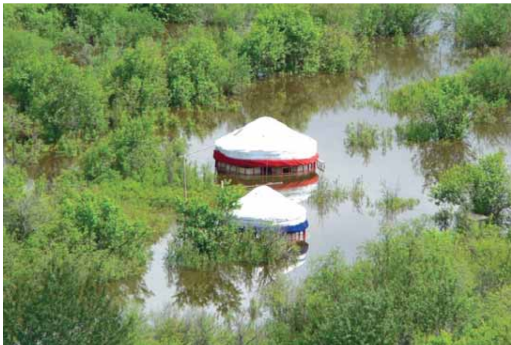
Рисунок 7.2. Стационарные бетонные «юрты» туристического приюта в пойме р. Геньхэ во время паводка. Хулунбуир, АРВМ. Фото Daniel Hanisch
