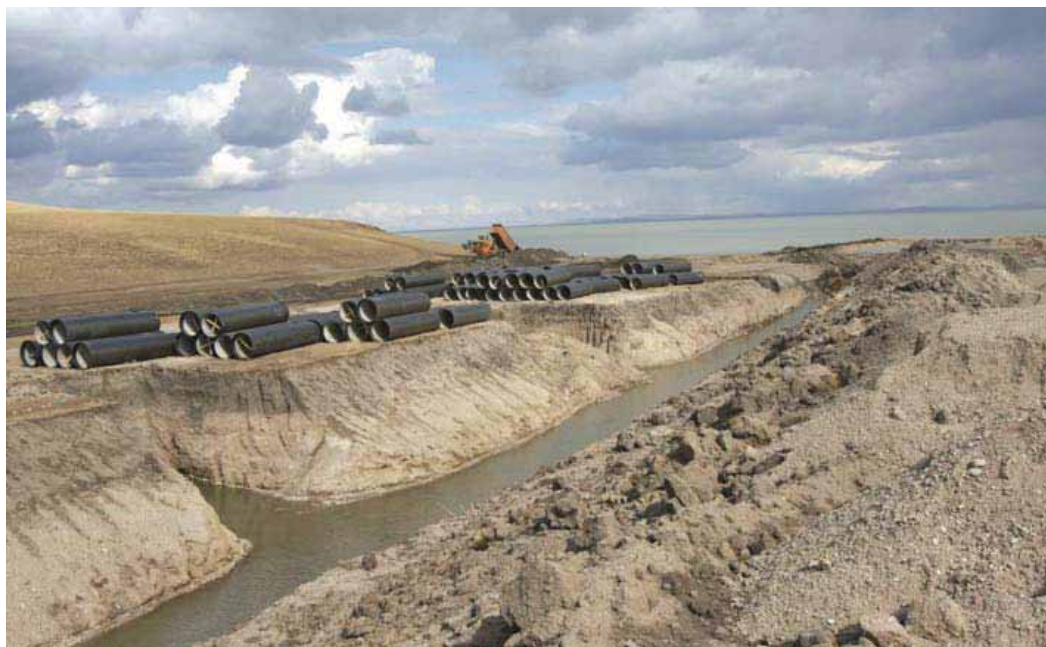
Рис. 7. 13. Строительство водовода от оз. Далайнор к руднику, 2008 г. Хулунбуир, Китай
